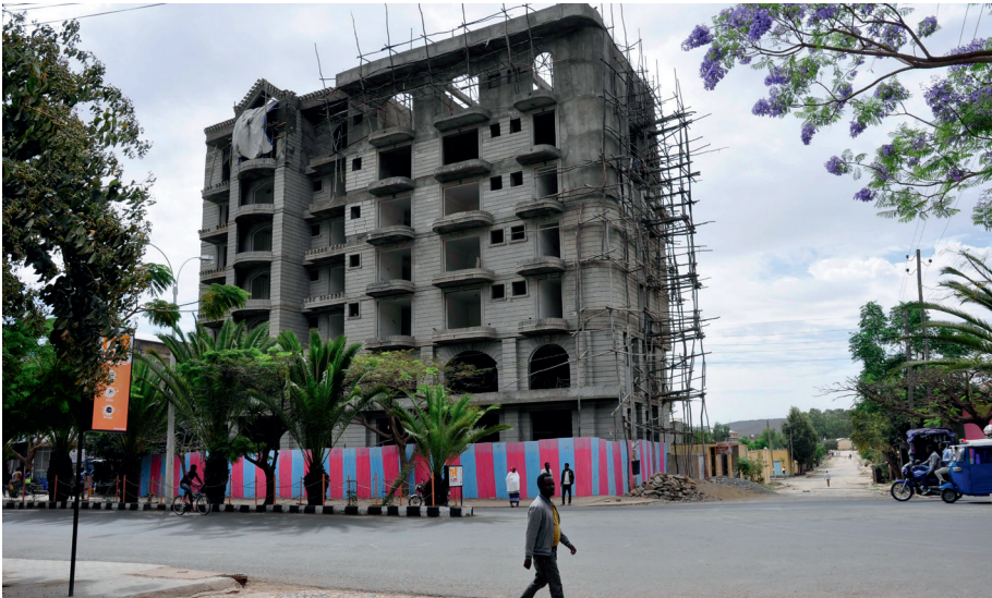
Manche Bauten verharren schon seit Jahren als Rohbau – ihre Bauherren warten auf das notwendige Geld, damit es weitergehen kann.
